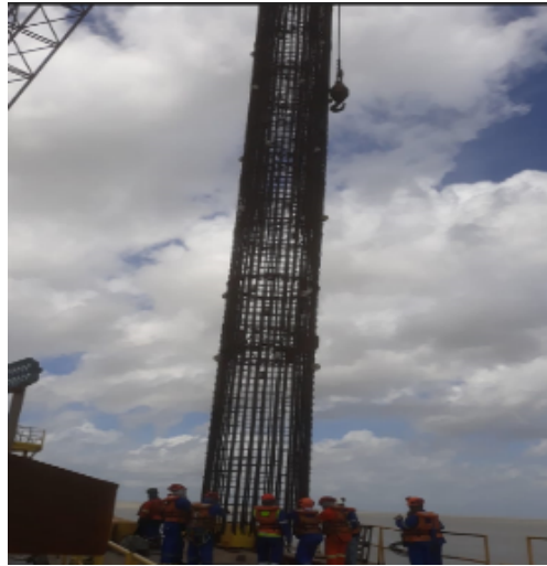
Figura 3. Armação sendo posicionada no canteiro avançado.
