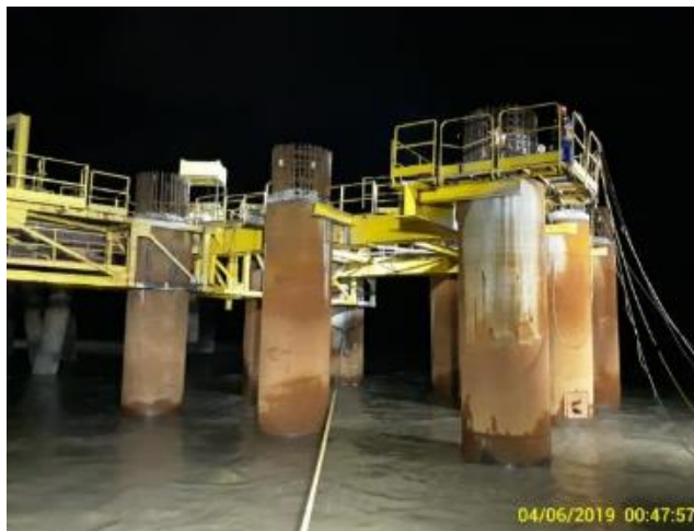
Figura 2. Estaca escavada de concreto com camisa metálica perdida.
